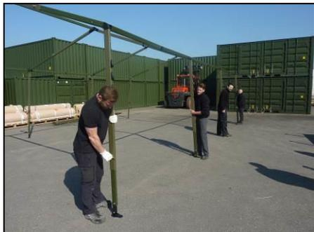
A quatre personnes minimum et du même côté, retirer la goupille et l'axe de la barre de pied.
