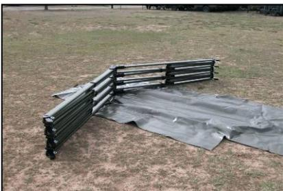
Déplier la charpente jusqu'à ouverture complète tout en laissant les faîtières en appui sur le sol ce qui permet de limiter les efforts.
