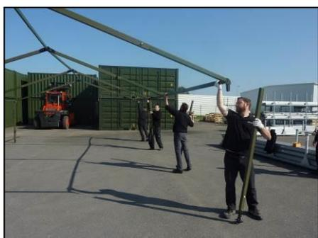
A quatre personnes minimum et du même côté, soulever l'armature et retirer les barres de pied simultanément.
