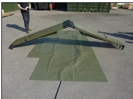
Placer le sac sous la charpente et la coucher dessus.
